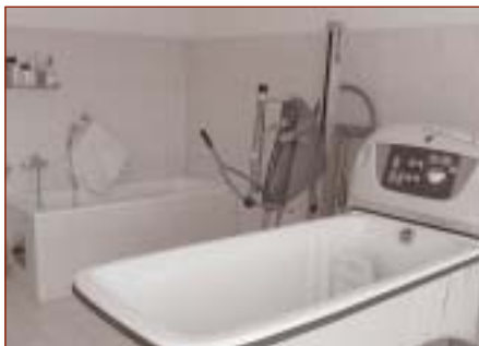
Rehabilitačná miestnosť, Hospic sv. Alžbety
