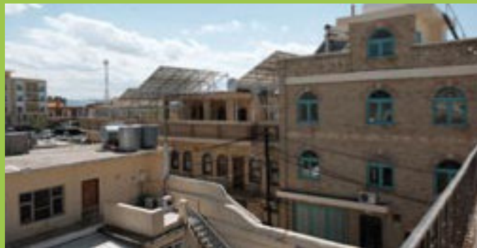
Zabezpečenie elektrickej energie a teplej vody pre kláštor Maryam al-Adhra (Irak)
